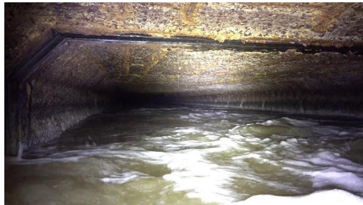
水位・流速が速く飛行困難な箇所
