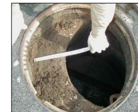
ボルト無緊結の古いタイプのマンホール蓋の横ズレ
