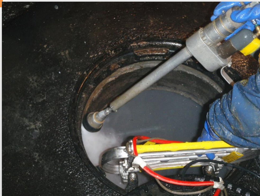
150MPa超高压水処理状況
