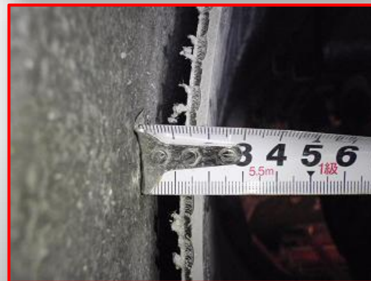
ボード裏面隙間 15mm
