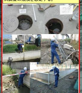
被害を受けている下水道施設の絞込みを行い、被害をうけている施設に立ち入ってその被害状況をTVカメラ調査や詳細測量、写真等に残す作業を行う。
