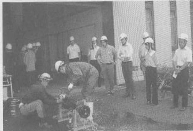
漏水補修金具を取り付けて水を止める
