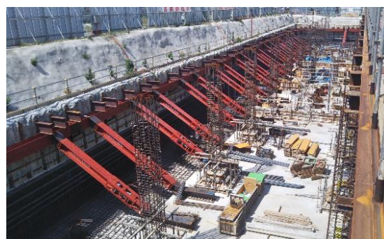
写真-1 アイランド工法適用状況
