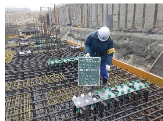
写真-3 アンカーボルトの埋め込み
