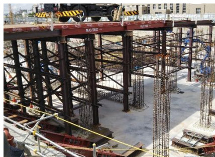
写真- 4 底版上への仮栈橋の設置
