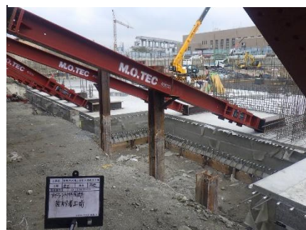
写真- 5 長い斜梁への棚杭の設置
