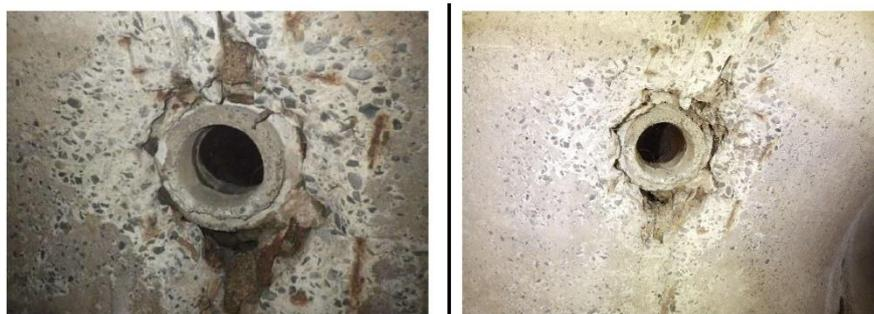
**図 3 同一劣化個所の比較（左が潜行目視調査時、右がドローンによる調査時）**
