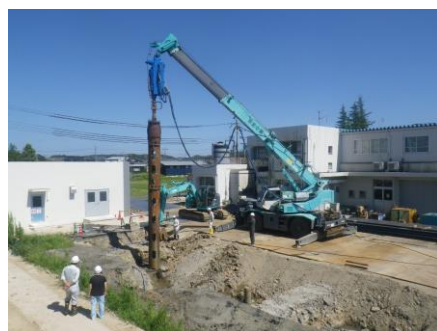
写真-1 杭引き抜き状況
