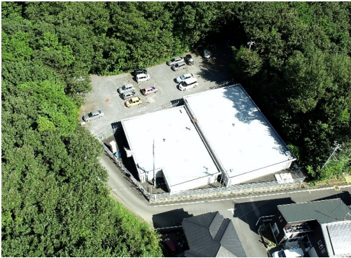
図 1. S 配水池航空写真
