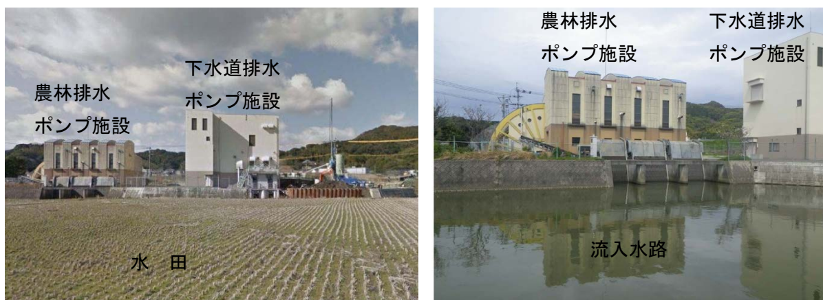
写真-1. 排水ポンプ場の立地状況
