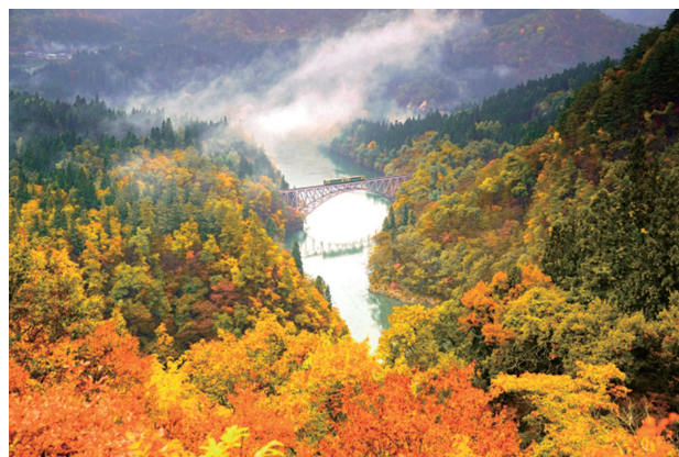
写真-1 只見川第一橋梁
