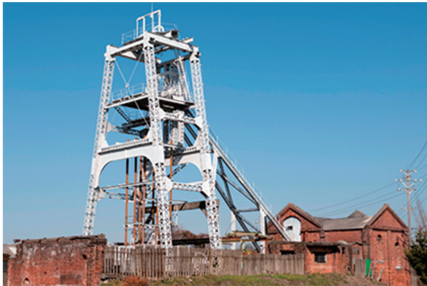
写真－1 三池炭鉱宮原坑
