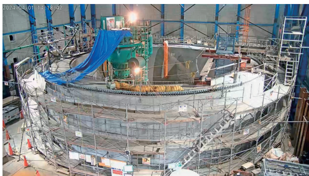
写真－2 立坑築造状況
