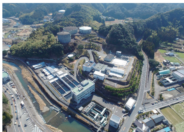
写真－1 河頭浄水場
