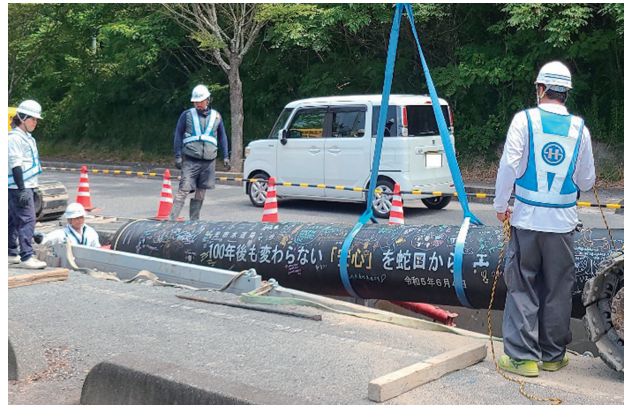
写真-2 タイム送水管布設状況
