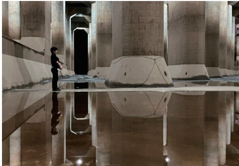
『地下神殿（首都圏外郭放水路）』 梶川 努（オリジナル設計株式会社）
