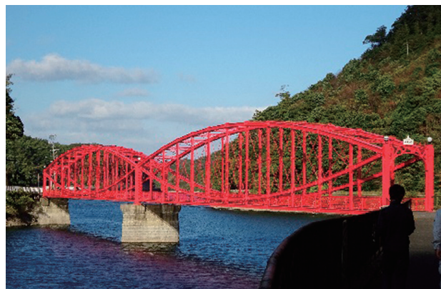
写真－2 南河内橋（2023年）
