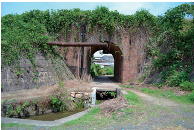
写真－2 煉瓦でできたトンネル（三池炭鉱専用鉄道敷）
