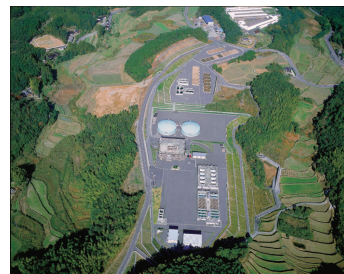
写真－1 日積浄水場
