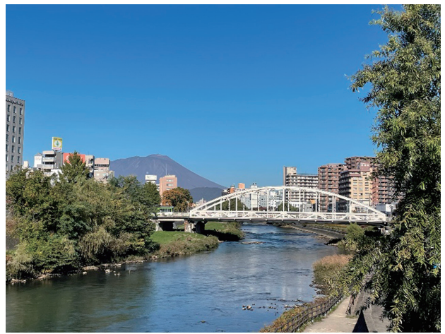
写真－1 北上川に架かる開運橋と岩手山の様子
