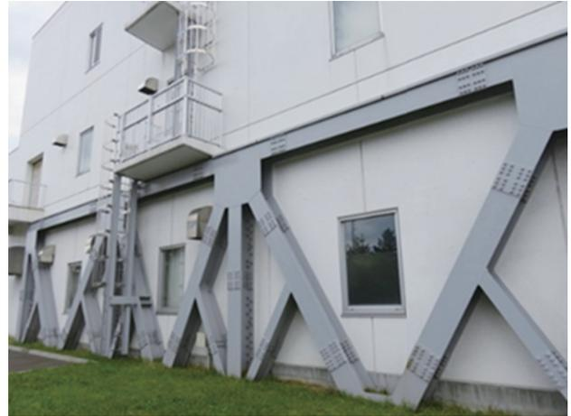
写真－6 処理施設の耐震化
