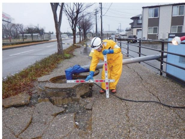
写真-1 一時調査状況（人孔周辺の被災確認）
