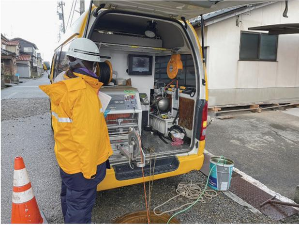
写真-2 二次調査状況（テレビカメラ管内調査）
