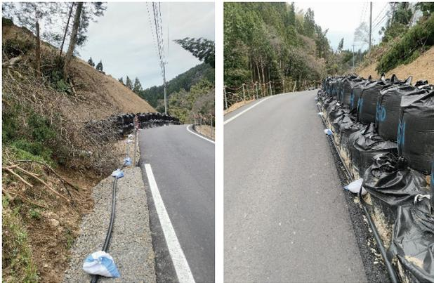
写真-7 中屋配水池仮設流入管布設状況
