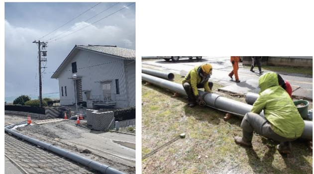
写真-2、3 「仮設」圧送管布設状況
