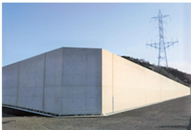
写真-3 高陽取水場の浸水防止壁
