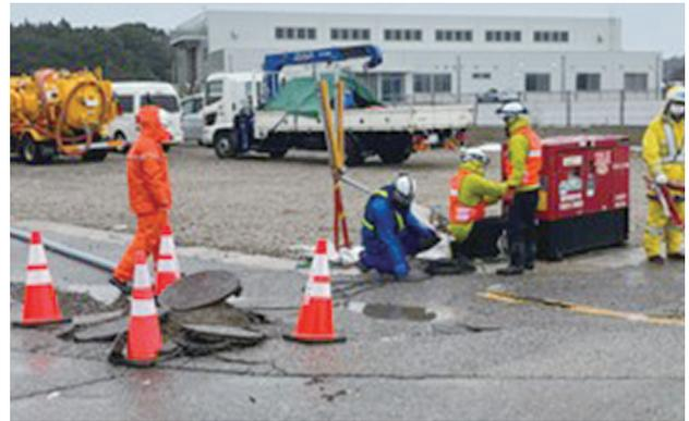
写真-5 仮設排水ポンプの設置
