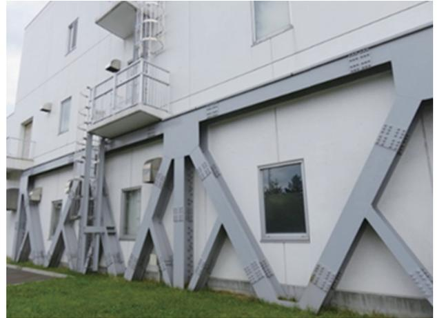
写真－6 処理施設の耐震化
