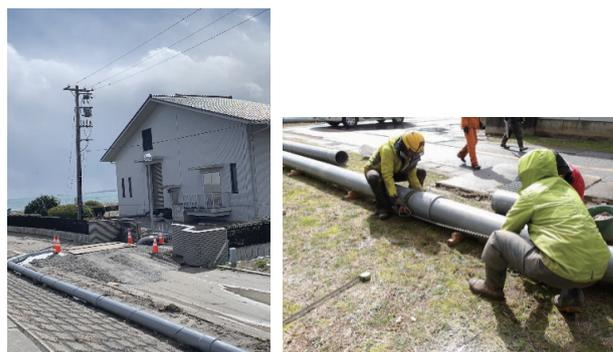
写真-2、3 「仮設」圧送管布設状況
