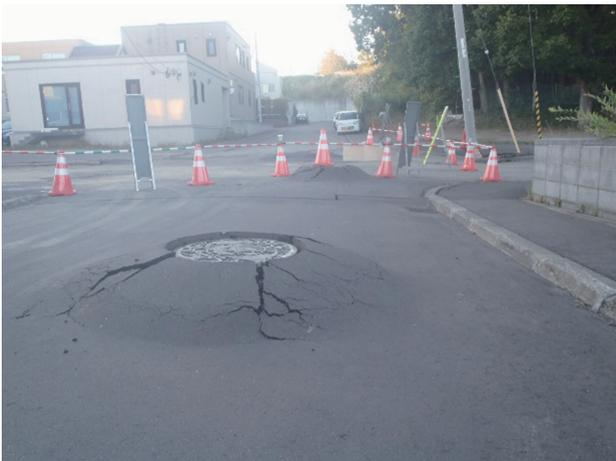
写真－5 被災状況（浮上したマンホール）
