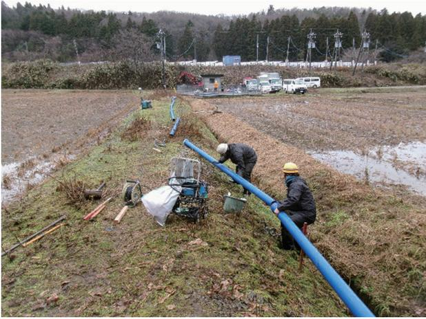
写真-2 岩屋浄水場導水管の仮設管
