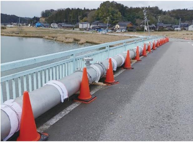
写真-5 赤浦水管橋の仮設管
