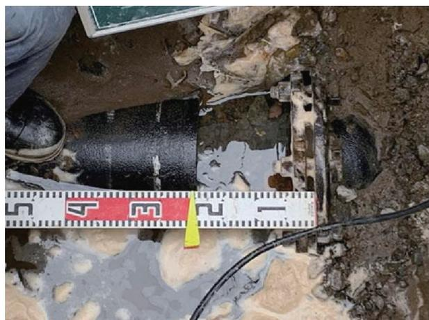
写真－1 圧送管抜出し状況
