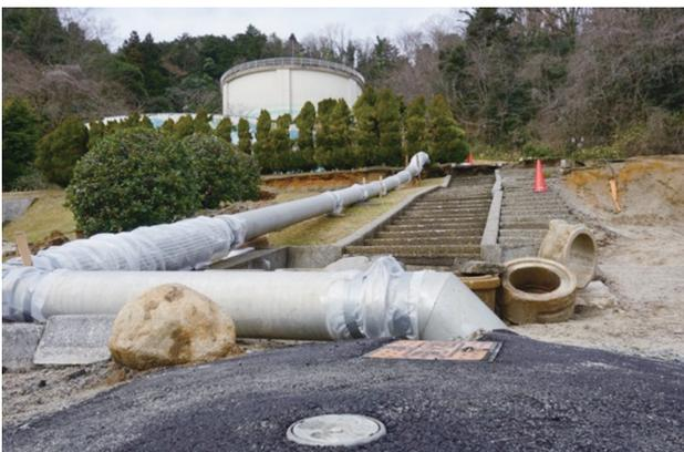
写真-3 岩屋浄水場流出管の仮設管
