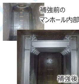
写真-2 マンホールの耐震補強
