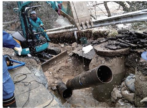
写真-5 復旧作業および仮設配管施工状況 (応急復旧班)
