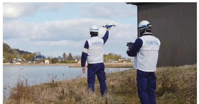
写真-4 ドローンによる赤浦水管橋の調査
