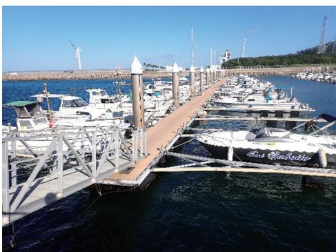
写真-3 プレジャーボート用浮棧橋（北九州市の施設）
