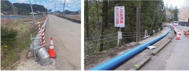
写真－3 仮設配管（転がし配管の活用事例）
