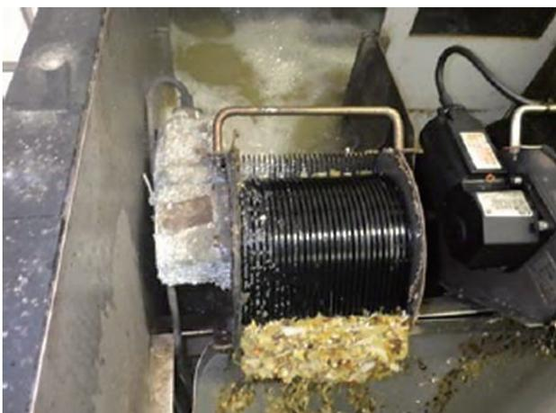
写真－3 処理施設内の自動微細目スクリーン
