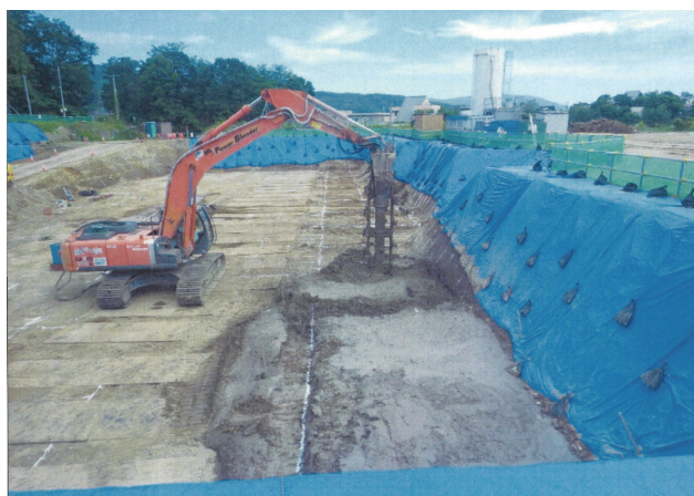
写真-3 工事中の低区配水池（地盤改良工事の状況）
