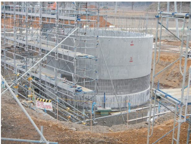
写真-3 新設井戸の施工状況
