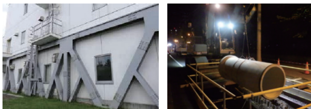
写真－1 水再生プラザや管路の耐震化
