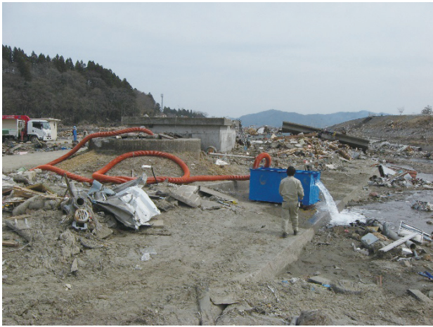
写真-2 既設井戸の応急復旧
