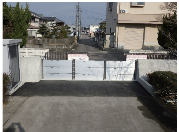
写真－２ 各務原浄化センター耐水化工事（R4年度）
