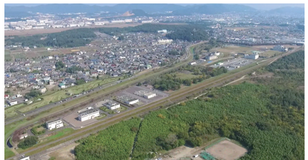
写真－１ 各務原浄化センター（木曽川右岸流域下水道事業）
