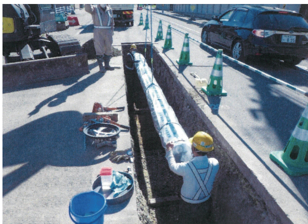
写真-2 配水管更新工事の状況
