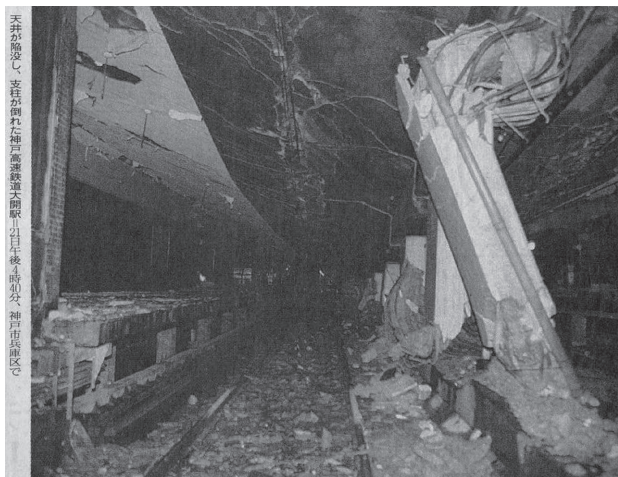
写真-3 阪神大震災時の地下駅舎（大開駅）崩壊の様子 （出典：朝日新聞1995年1月22日朝刊）
