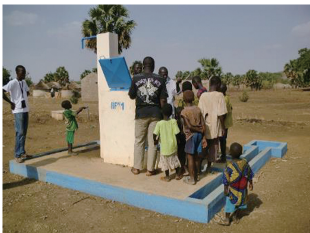
写真－4 完成した共同水栓
