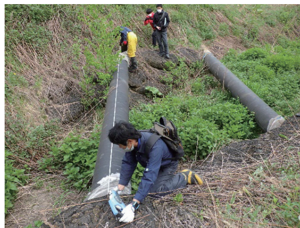
写真-4 導水管定期点検状況
