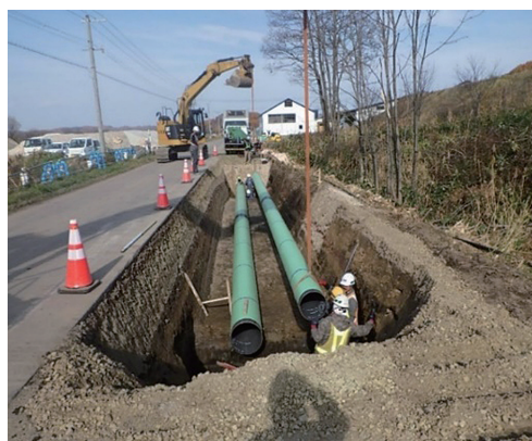
写真－5 導水管布設状況
