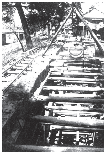
写真－2 乙川遮集管施工の様子
