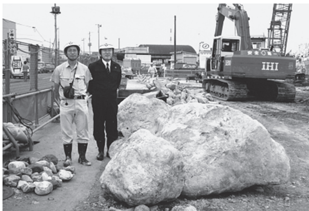
写真-1 到達立孔内から出土した巨礫
