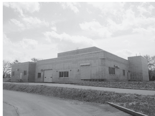
図－8 雨水滞水池
