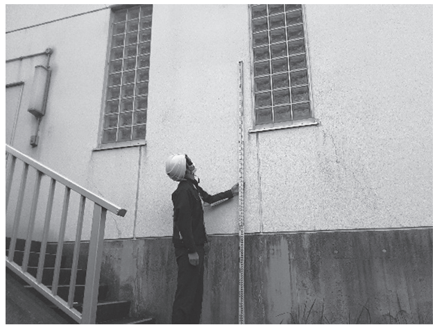
写真-1 現地調査の様子 (浸水深と浸入経路の現地確認)
