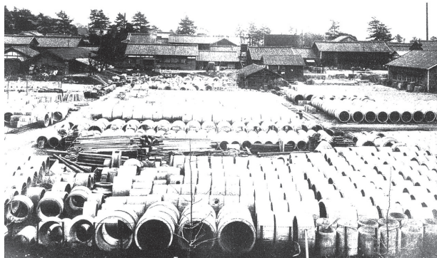
写真－1 下水管直営工場の様子
