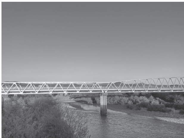
写真-2 雫石川と水管橋
