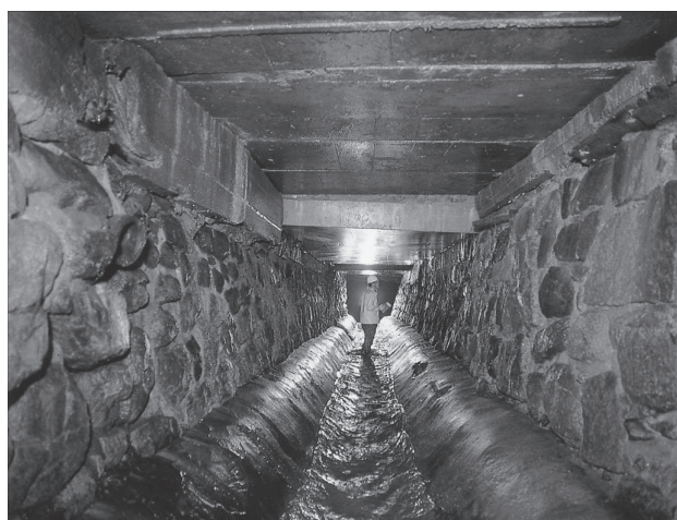
写真－1 暗渠化された太閤（背割）下水の内部
