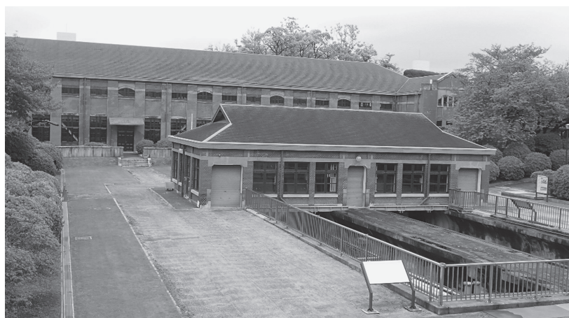
写真－1 旧三河島污水処分場唧筒場施設全景
