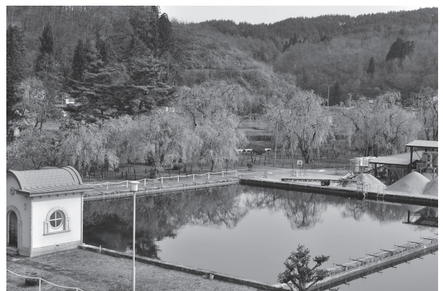
写真－１ 緩速ろ過池とヤエベニシダレヒガンザクラ
