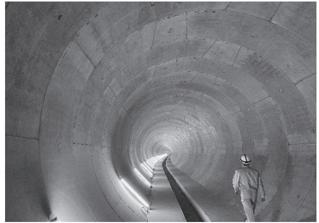
写真-4 完成した雨水渠内部
