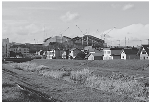
写真－1 建設中のボールパーク
