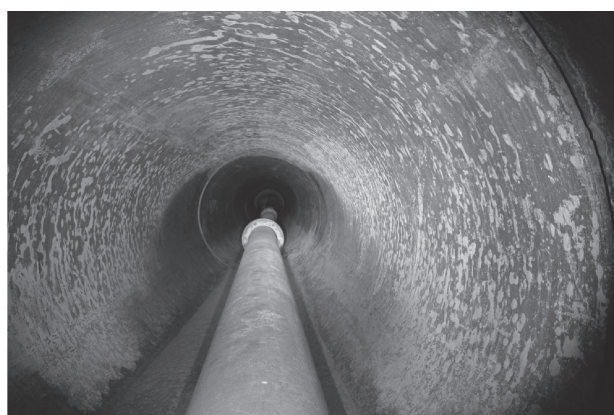
写真-6 内部撮影状況 2
