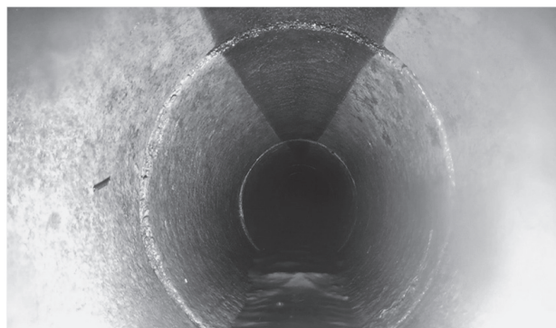
写真-9 貯水池底樋管内部 2
