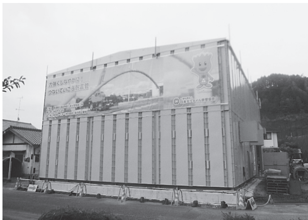
写真－2 防音ハウス
