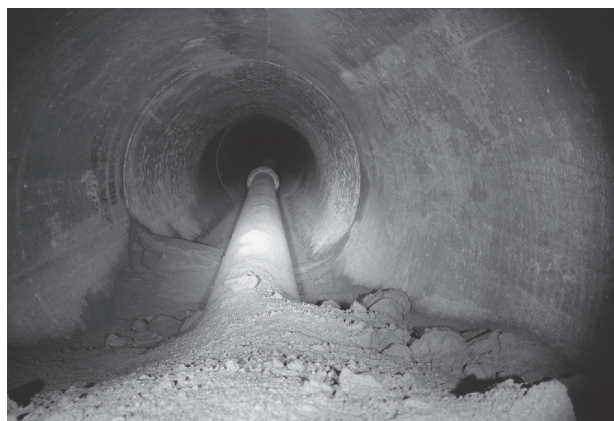
写真-5 内部撮影状況 1
