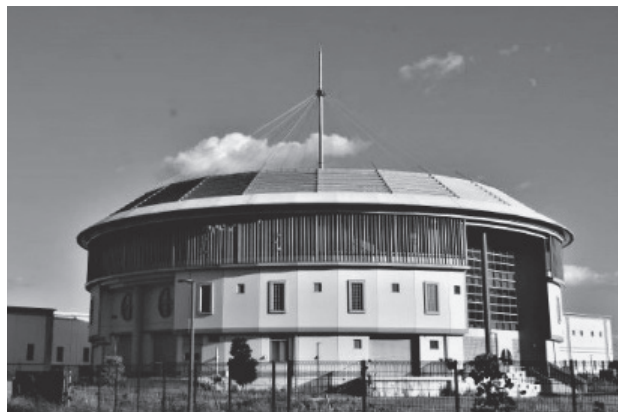
写真－８ ネットワークポンプ場
