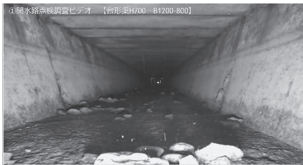
写真-7 トラフ内部
