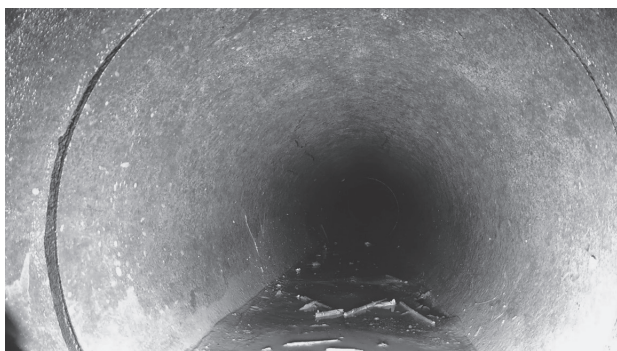
写真-8 貯水池底樋管内部 1
