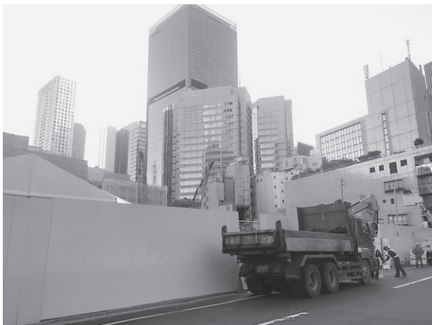
写真－1 建設が進む虎ノ門ヒルズ一帯 (旧当センター事務所跡地)
