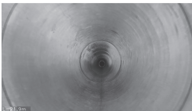
写真-4 Air Slider撮影状況
