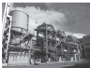
令和2年11月に稼働した下水汚泥固形燃料化施設
