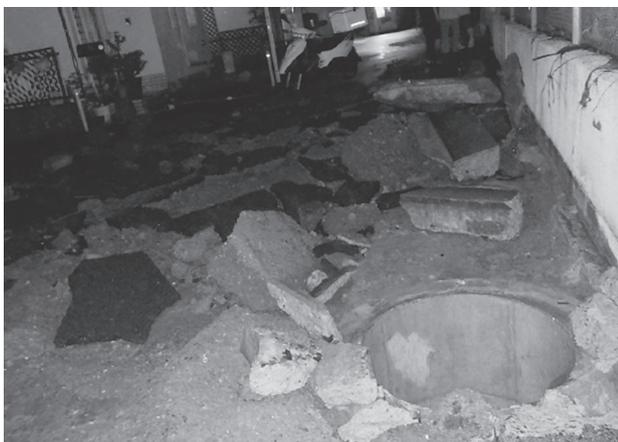
写真一 マンホール蓋の損傷
