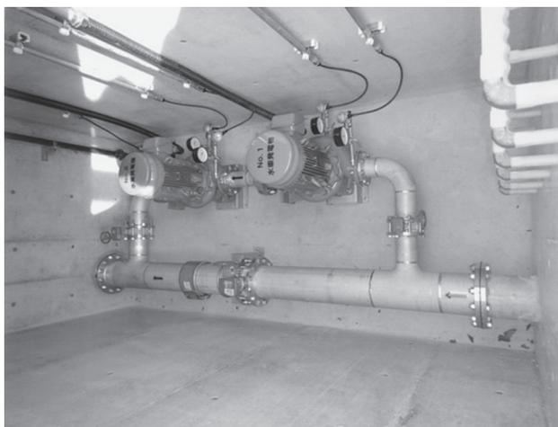
写真-1 小水力発電の施工状況
