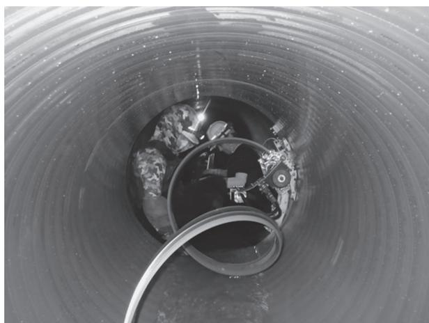
写真－5 SPR-NX工法の現場
