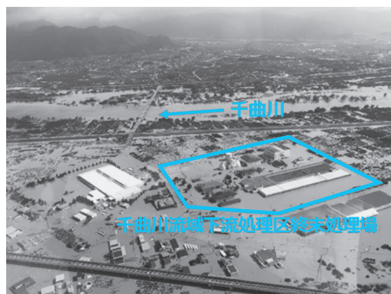
写真－1 令和元年東日本台風における被災状況
