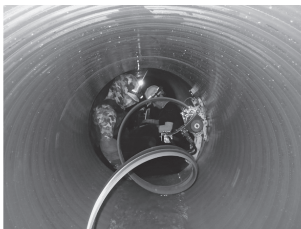
写真－5 SPR-NX工法の現場
