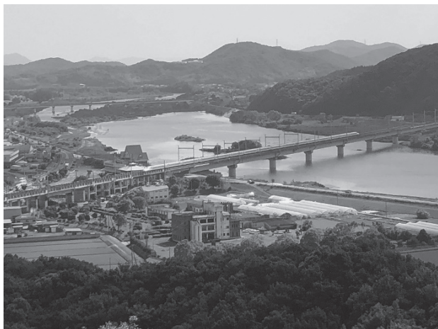
写真－２ 坂根浄水場の状況
