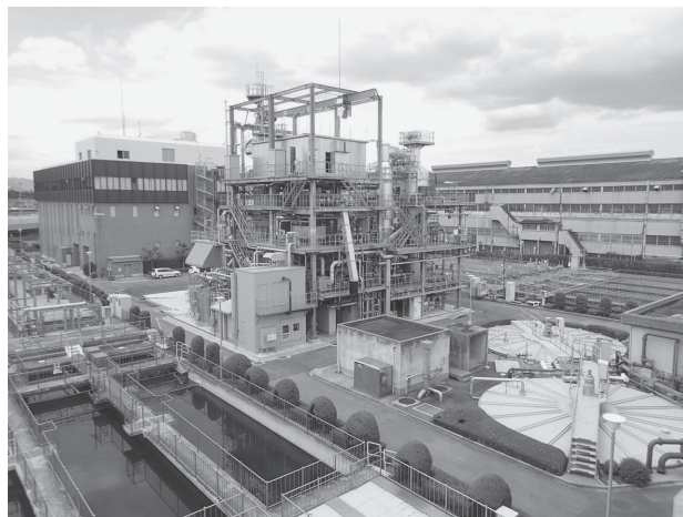
写真－4 平成25・30年度B-DASHのフィールドとなった池田市下水処理場
