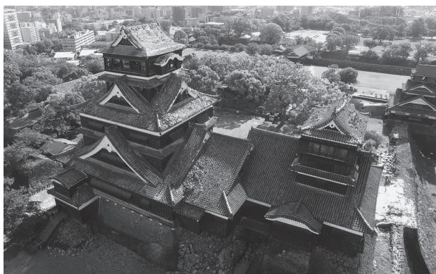
写真－1 熊本城の被災状況（天守閣）
