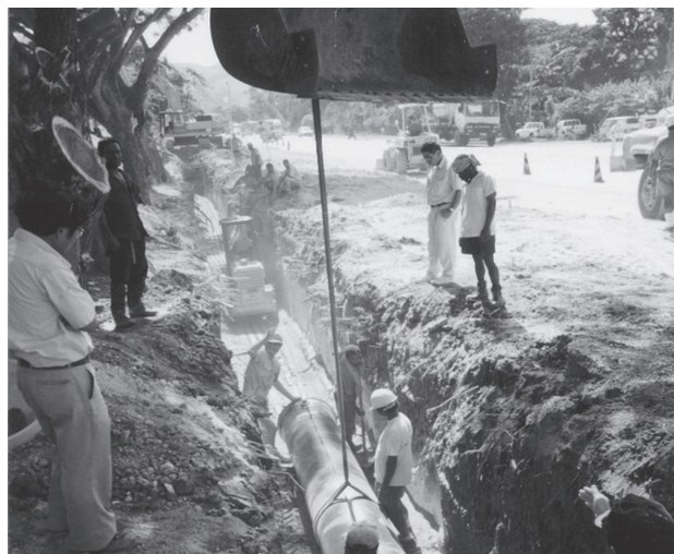
写真－2 街路樹を伐採して送水管施工
