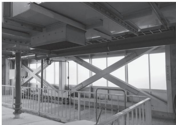
写真-3 建築施設の耐震補強例
