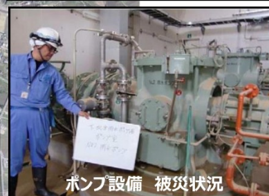
今回の豪雨において河川氾濫によりポンプ場が浸水し機能停止した事例。 (広島県三原市)
