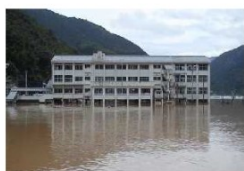
H26. 8 避難所2階の浸水(徳島県)
