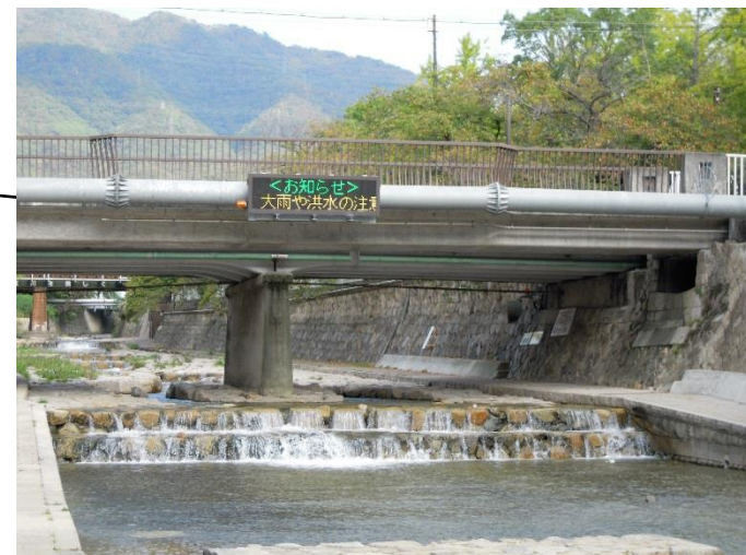
甲橋 (水位 ・カメラ 観測 箇所)
