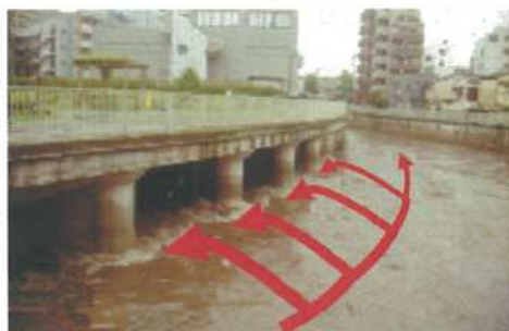
神田川取水施設の流入状況
