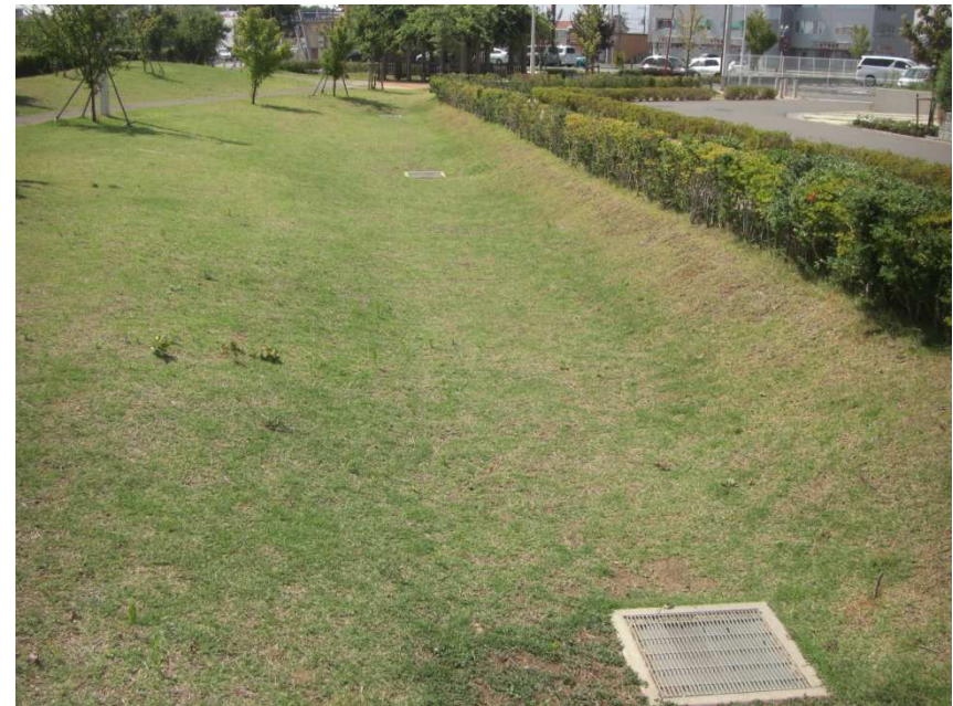
窪地に設置された浸透トレンチ
