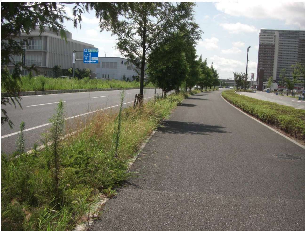
歩道部透水性舗装
