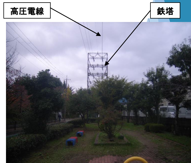
鉄塔付近の状況
