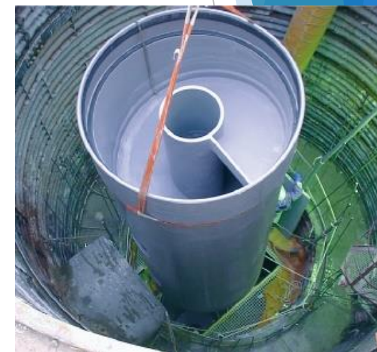
ドロップシャフト吊込時
