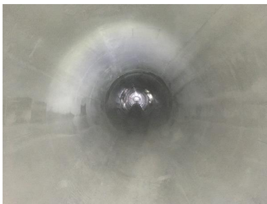
コンクリート打設完了
