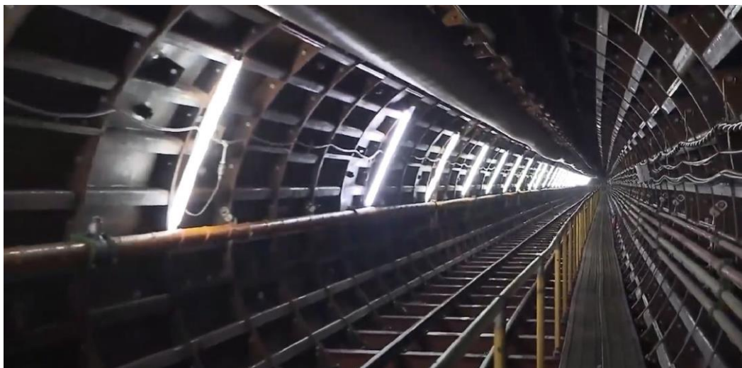
一次覆工完成時
