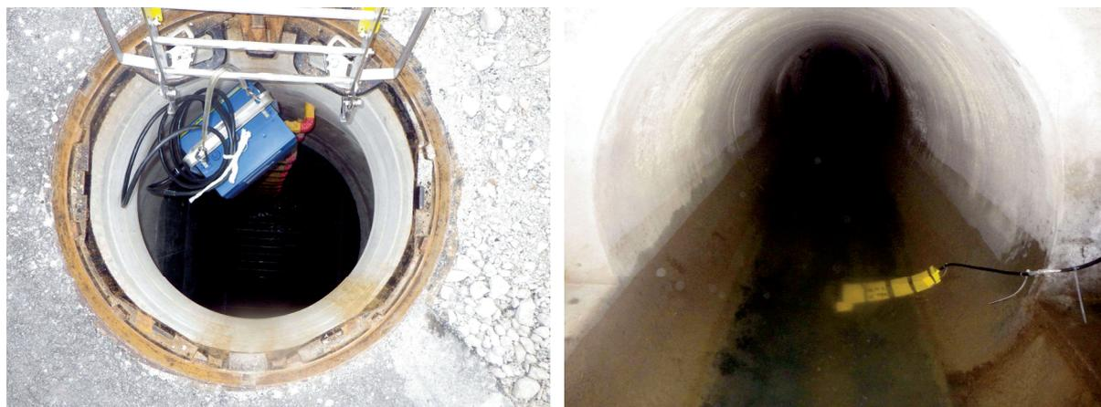
写 4.3.1 面速式流量計の設置状況
