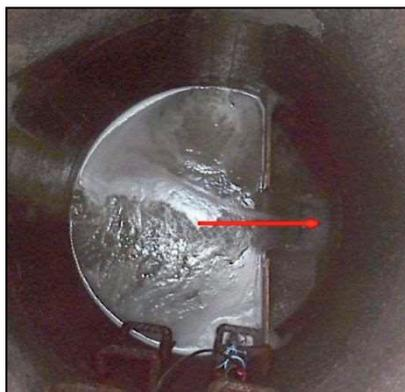
写 2.1.9 気泡発生における圧力式水位計の設置例
