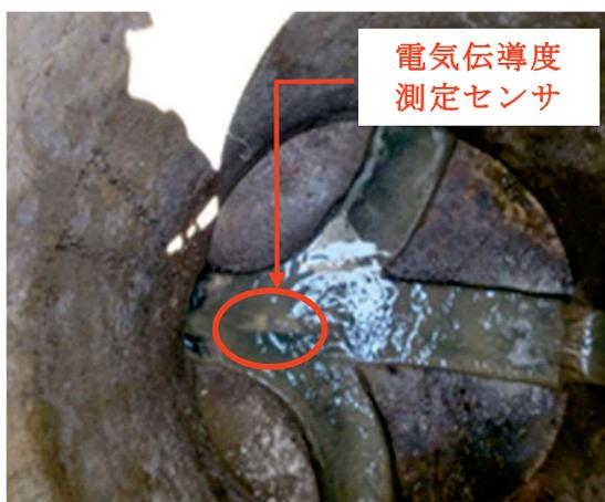
図 4.4.1 電気伝導度測定装置設置例
