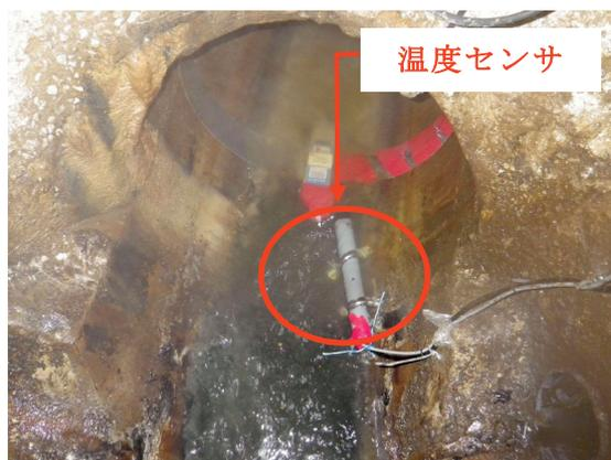
図 4.2.2 管路内への温度センサ設置例
