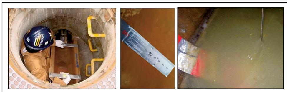
写 2.1.10 フリューム仮設と金尺による水位測定
