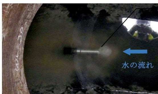
きょう雑物絡み防止対策として、センサをアンカーボルト等で固定後、速乾性モルタルまたはパテで先端部の突起の解消策を実施。
